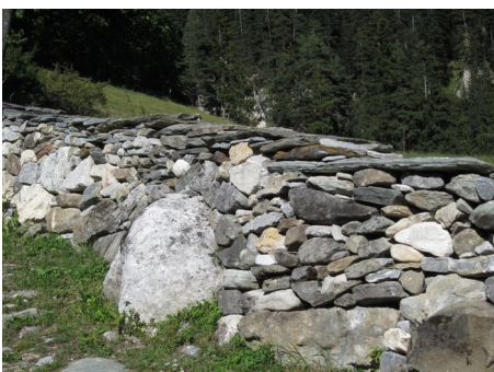
Mur de soutènement avec couvertine en larges dalles de pierre de pays
