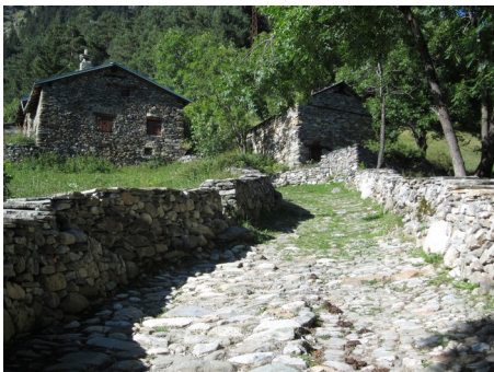
Chemin creux en calade et mur de soutènement ou de clôture
