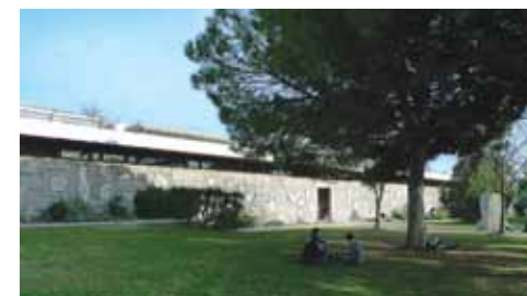
Façade ouest des bâtiments d'art et d'archéologie. Le Musée des moulages avec son mur cyclopéen d'Albert Dupin, et, au-devant, l'espace vert. Université Paul-Valéry Montpellier 3.
