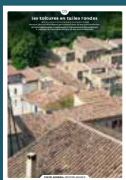
05 les toitures en tuiles rondes
