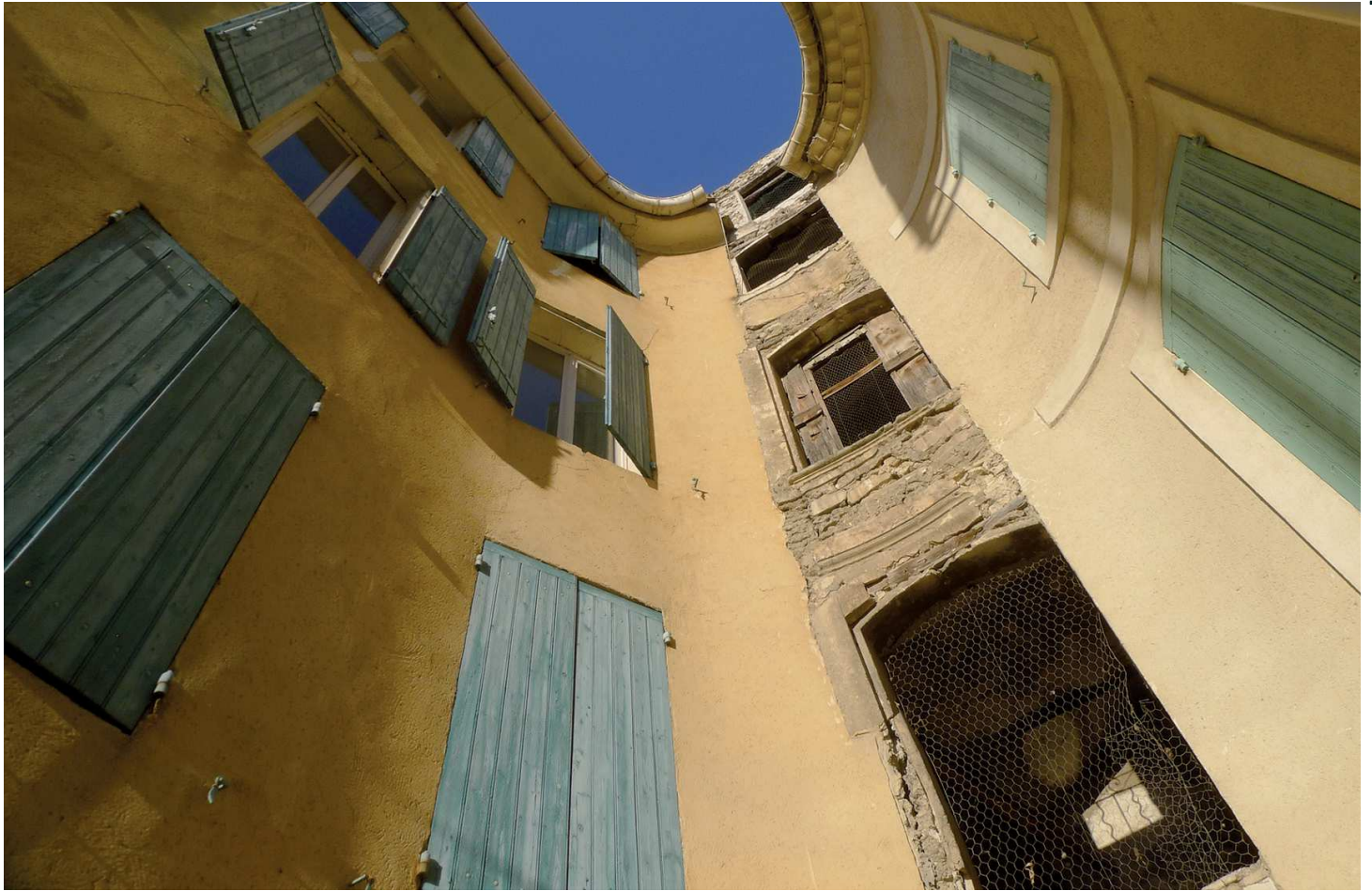
FIG. 7. Vue de l'immeuble Beaucaire dans le quartier juif de L'Isle-sur-la-Sorgue (Vaucluse). Cliché F. Guyonnet.
