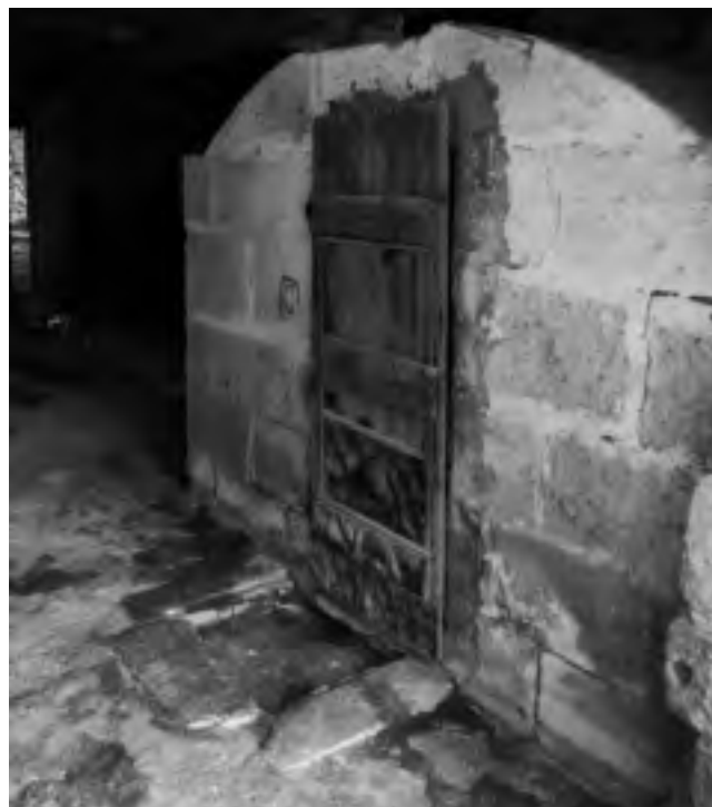
Fig. 115 – PORT-DE-BOUC, mas de l'Hôpital. Vue de la chambre froide et son petit bassin à l'entrée (cliché H. Marino / SAVM).
