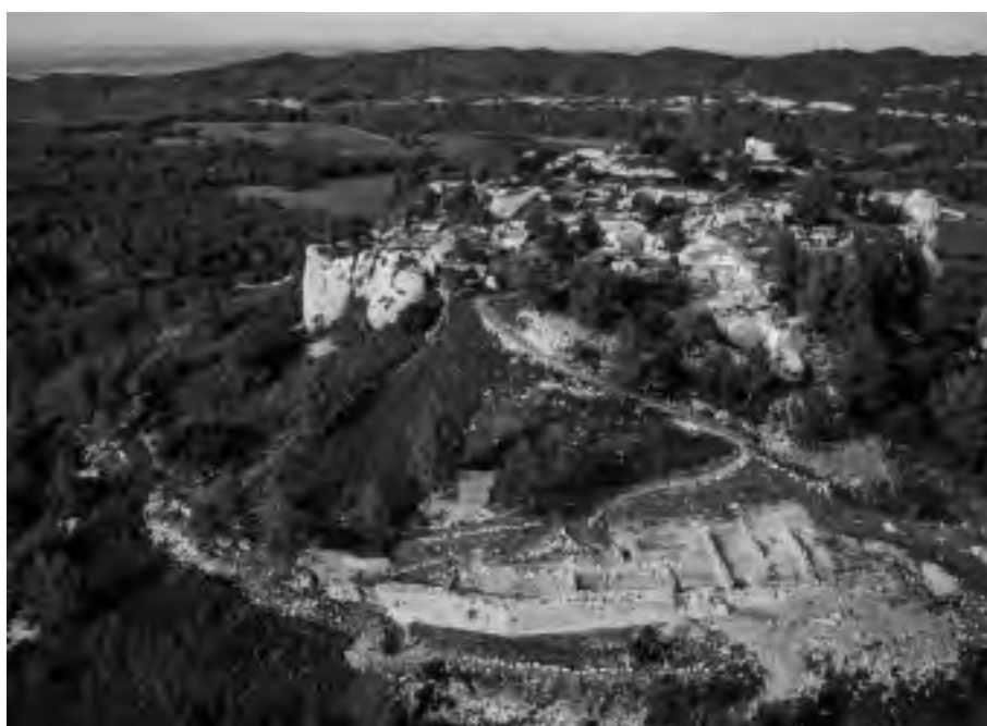
Fig. 85 – FONTVIEILLE, Montpaon. Vue aérienne du castrum depuis le sud, prise par drone (©Dronimage 2013).
