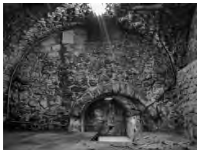
Fig. 55 – AIX-EN-PROVENCE, centre-ville. Vue depuis l'ouest de la cave et de l'espace souterrain sous la rue Thiers (cliché M. Panneau / DAVA).
