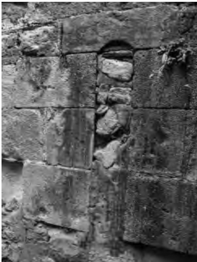
Fig. 61 – ARLES, hôtel du Cloître. Vue de la meurtrière dans l'enceinte canoniale (L. Deye / Hadès).
