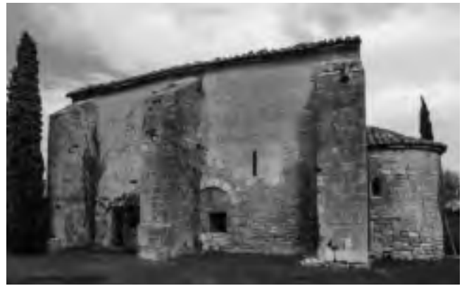
Fig. 184 – L'ISLE-SUR-LA-SORGUE. PCR. La chapelle Saint-Andéol de Velorgues (XI e -XII e s.) acquise par la Ville en 2013 suite à sa mise en vente sur le site Internet « leboncoin.fr » (cliché Fr. Guyonnet / DPI).
