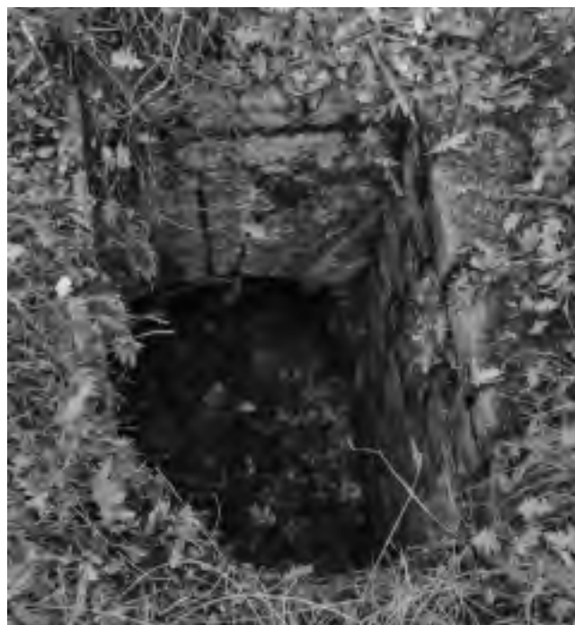
Fig. 132 – Aqueduc romain de Traconnade. Les regards rectangulaires de dimensions uniformes de 60 x 90 cm permettaient l'entretien de l'aqueduc (cliché B. Fino).
