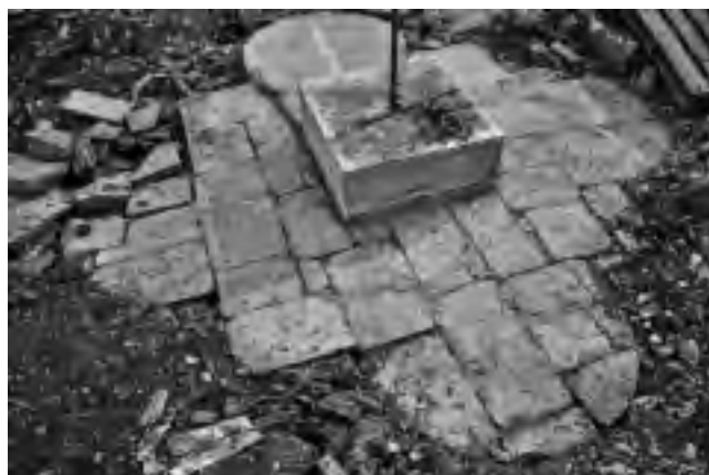
Fig. 34 – VENCE, place Antony Mars. Dallage situé sous la fontaine et faisant office de fondation (cliché R. Aimé / Hadès).
