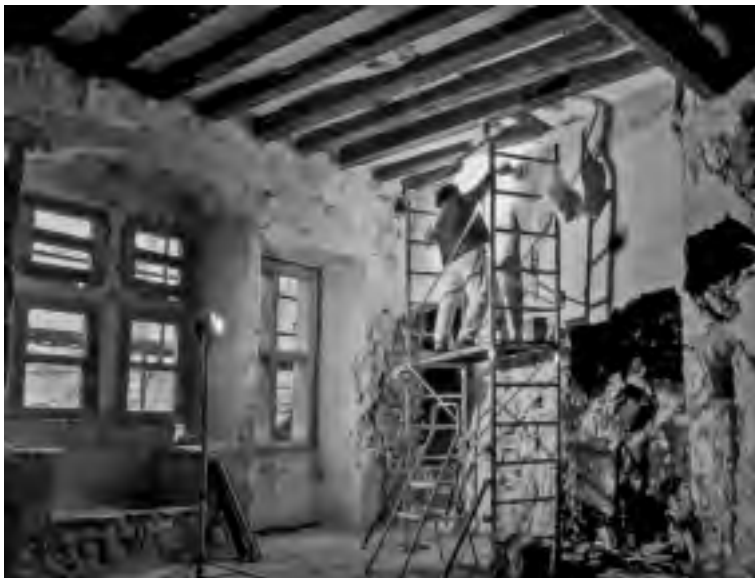
Fig. 192 – L'ISLE-SUR-LA-SORGUE, Tour d'Argent : bâtiment résidentiel. Pièce principale en cours de décloisonnement et intervention de C. Delhumeau sur les peintures murales du XV e s. (cliché Fr. Guyonnet / DPI).
