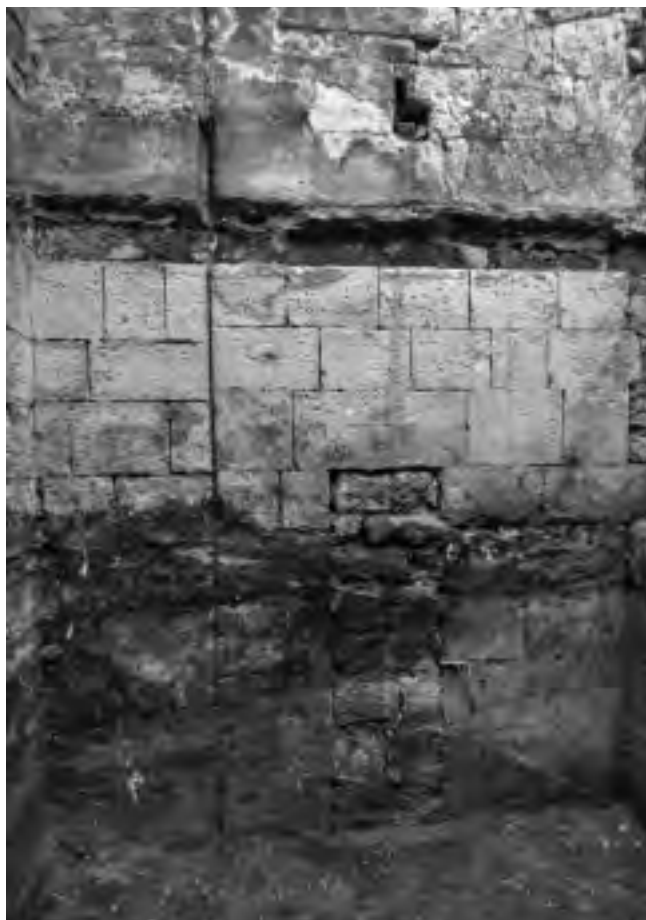
Fig. 62 – ARLES, cour du Presbytère. Vue de la baie (L. Deye / Hadès).
