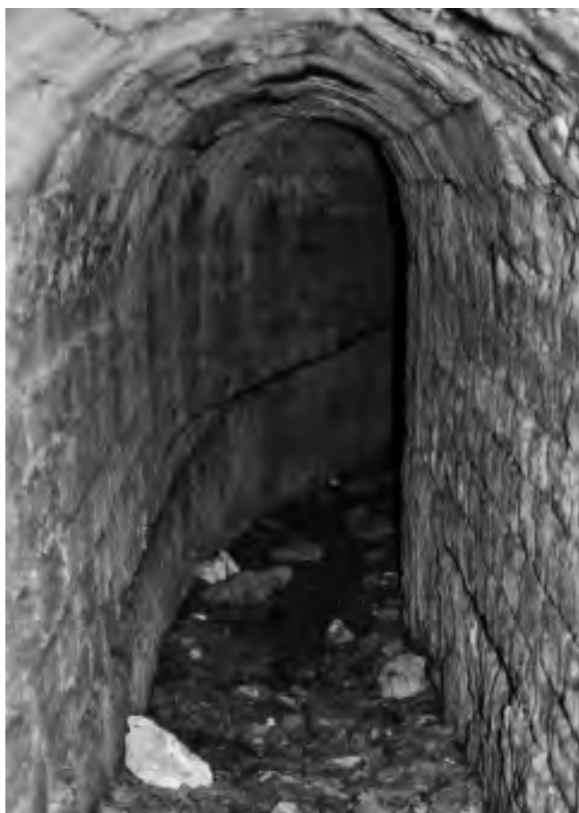
Fig. 131 – Aqueduc romain de Traconnade. L'aqueduc est principalement construit en tranchée en petit appareil. Il a 0,60 m de largeur et 1,80 m de haut au sommet de la voûte construite avec des voussoirs en pierres cimentées sur un coffrage dont on aperçoit les empreintes de planches (cliché B. Fino).
