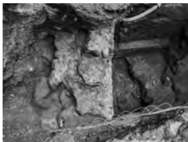
Fig. 47 – AIX-EN-PROVENCE, passage Agard. Mur gouttereau et mur intérieur dans la tranchée de diagnostic (cliché M. Panneau / DAVA).
