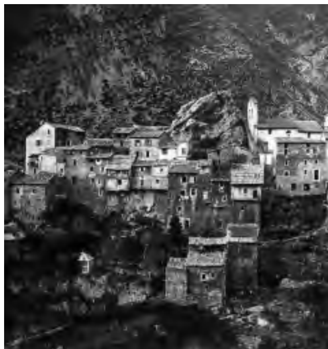
Fig. 37 – PCR « Alpi Marittime » vue du village de Pierlas (06) au début du XX e s. avec de nombreuses extensions bâties en bois (cliché AD.06, 10Fi1718).
