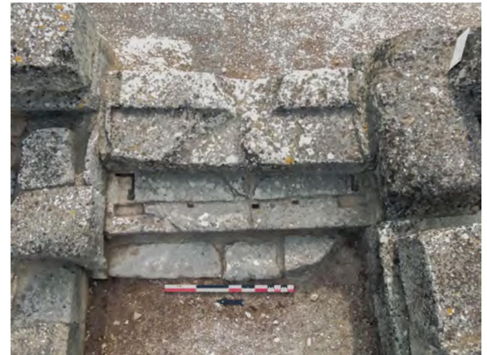
Fig. 117 – SAINT-RÉMY-DE-PROVENCE, Glanum, Salle d'assemblée dite « bouletérium ». Les deux états successifs de la porte, vus de l'ouest. Le seuil d'origine est surmonté d'un second mis en place à l'époque romaine (cliché G. Larginat-Turbatte/IRAA).
