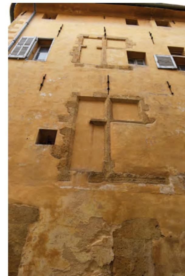
Fig. 60 – AIX-EN-PROVENCE, Hôtel de Gassier – 10, rue Mignet. État de la façade nord au démarrage de l'intervention, percée de deux grands fenêtres à croisée et d'une multitude d'autres ouvertures (cliché C. Auburtin/DAMVA).
