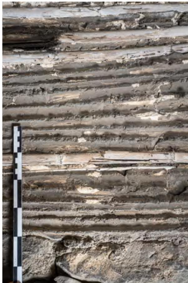
Fig. 172 – ORANGE, PCR « Architecture, technique et décor du théâtre antique ». Détails des négatifs de roseaux et roseaux encore en place sous la voûte (cliché L. Damelet/CCJ, 2020).
