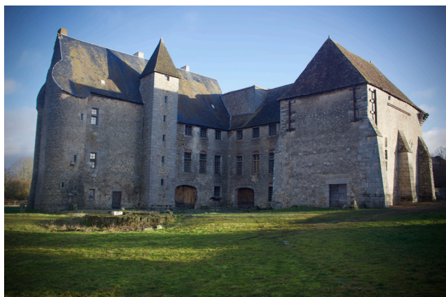
Fig. 1 - Vue de la commanderie depuis le nord-ouest.
