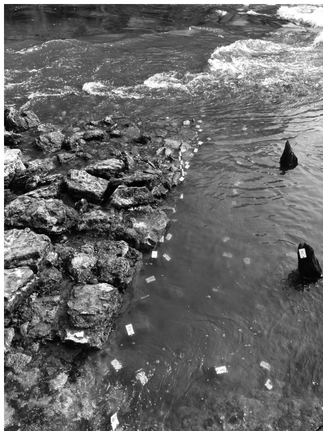
Dax – Berges Adour Vue générale du batardeau en cours d'enregistrement W. O'yl
