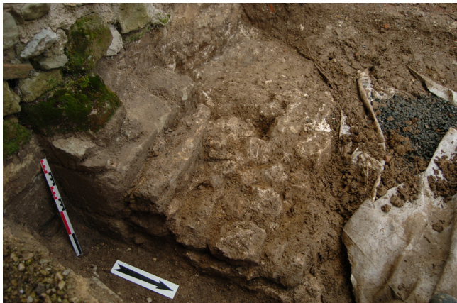
Leigné-les-Bois - Église Saint-Rémi Maçonnerie s'appuyant contre l'ancien contrefort plat romain (cliché : D. MARTINS, Inrap)
