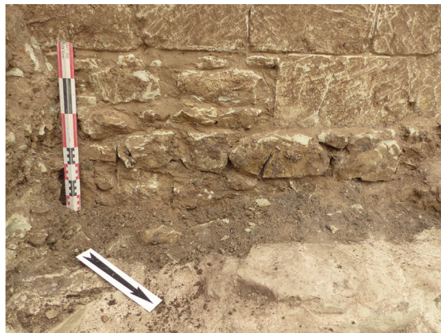
Monts-sur-Guesnes - Le Château Base de courtine en moellons équarris (cliché : D. Martins, Inrap)
