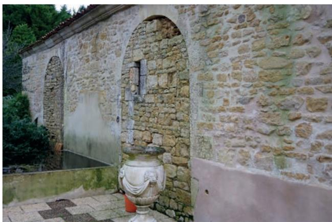
Charron, abbaye de la Grâce-Notre-Dame, fig.1 : Vue de la façade ouest de l'aile est, avec vue sur deux arcades bouchées appartenant au dernier état de l'abbaye. Au fond une arcade plus ancienne se devine (Cliché : J. Fillonneau)
