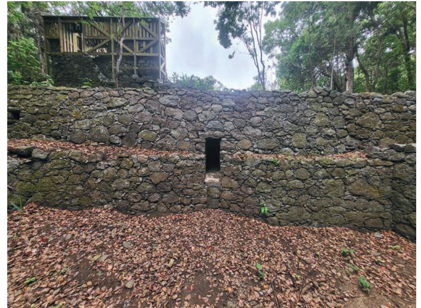
[Fig. 2]: L'exutoire restauré et, en arrière-plan, le mur gouttereau ouest de la chapelle provisoire consolidé, vue vers l'est (photo V. Mialhe / Inrap)
