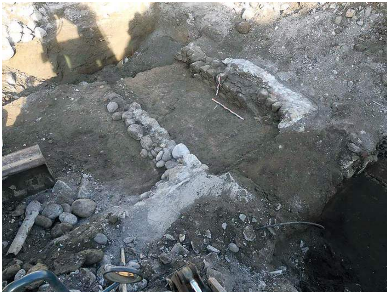
[Fig. 9] : Vue des fondations de murs de l'ancienne crèche (photo N. Biwer / Inrap)
