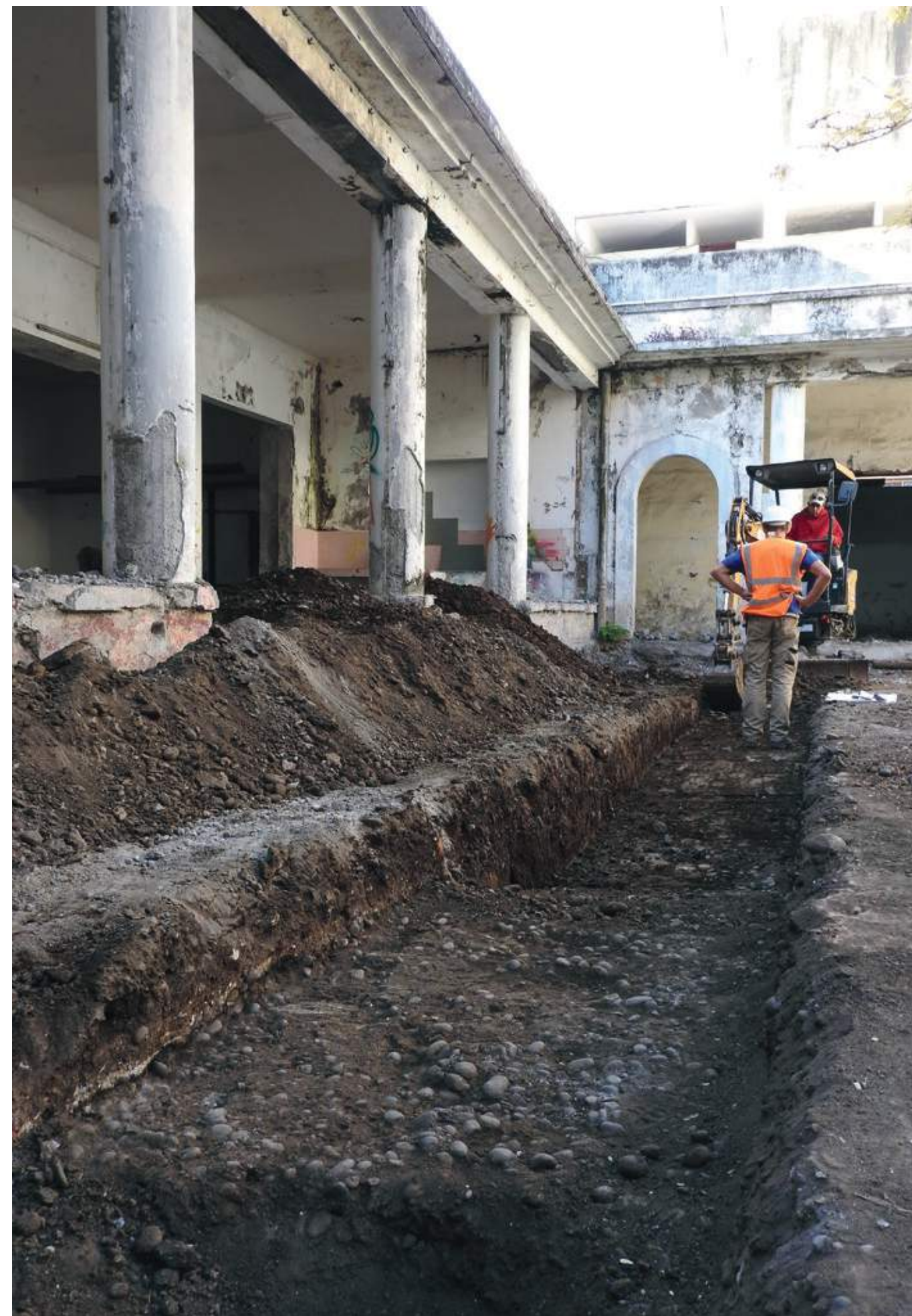
[Fig. 1]: Terrassement d'une tranchée dans la cour des bâtiments encore en élévation (photo J. Cornec / Inrap)
