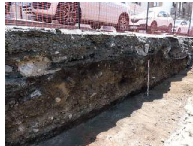
[Fig. 3] : Sondage 3, maçonneries des XIX e et XX e siècles construites sur le remblai corallien (photo Th. Cornec / Inrap)
