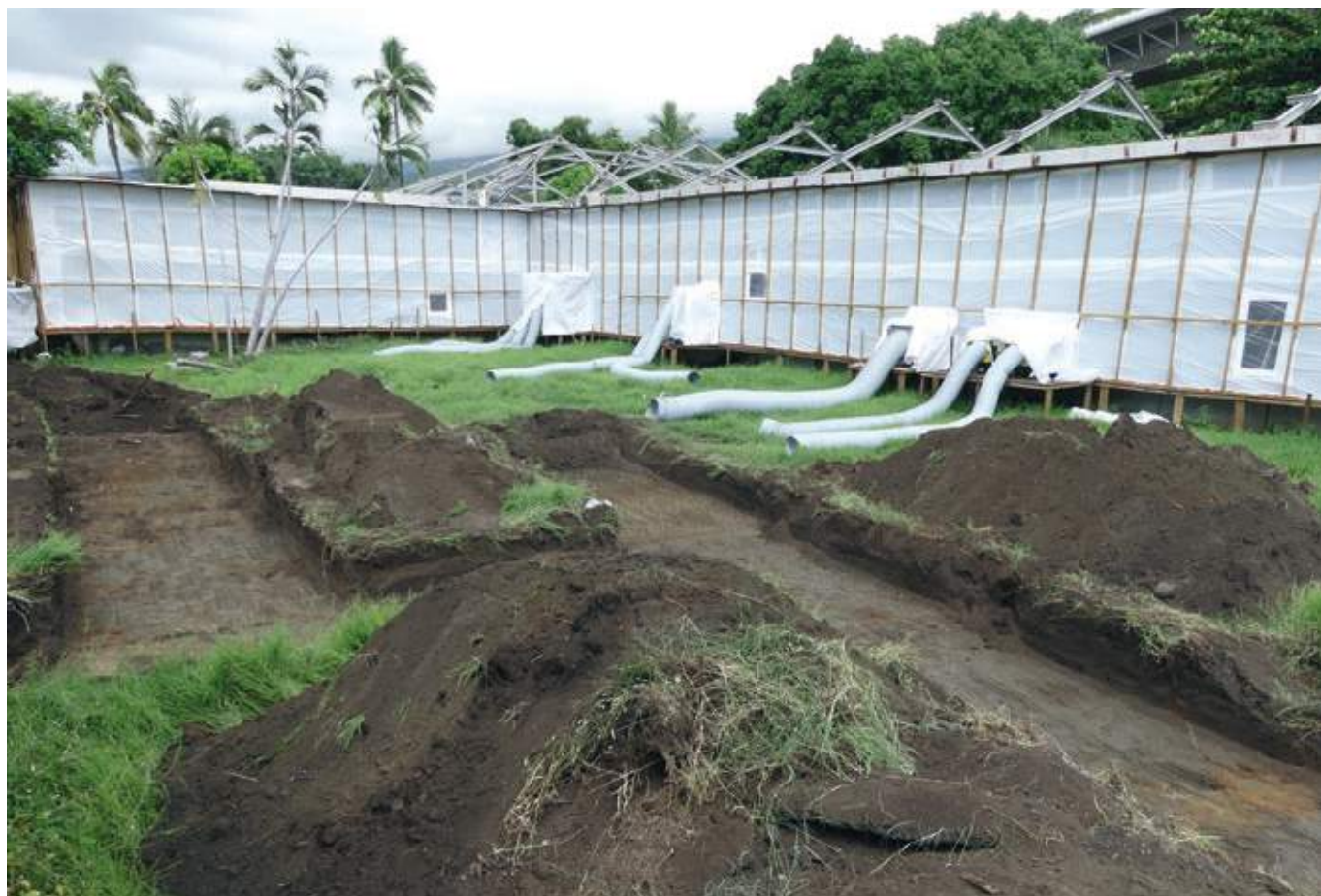
[Fig. 2]: Tranchées de diagnostic et bâtiment en cours de désamiantage (photo Th. Cornec / Inrap)
