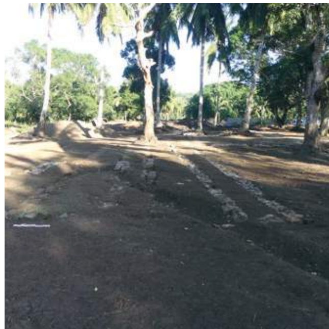
[Fig. 9]: Fondations de séchoirs (photo C. Grancha / Inrap)
