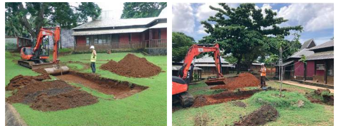
[Fig.2]: Creusement des tranchées sous l'œil attentif des archéologues (photo N. Biwer / Inrap)
