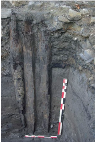
Phase 2 : pioux de chêne employés dans les radiers de fondation des murs de berge (fin du XIII e s.).
