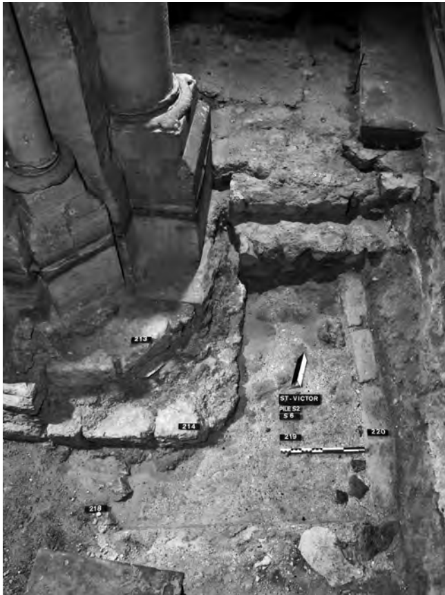
Fig. 119 – MARSEILLE, Saint-Victor, église haute. Pile S2, vue sud-nord, côté est. Butant contre la fondation de la pile médiévale, l'extrados avec sa clé de voûte de l'entrée de la chapelle Notre-Dame de Confession dans les cryptes (cliché M. Moliner / SAM).
