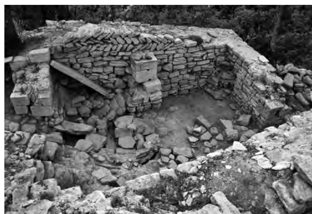
Fig. 175 – AURIBEAU, castrum Saint-Pierre. L'espace F vu depuis le nord-ouest (cliché M. Dadure / SADV).
