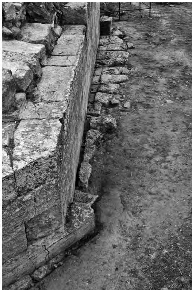
Fig. 151 – SAINT-MITRE-LES-REMPARTS. Saint-Blaise. Assise de fondation du mur F du bastion sud de la muraille grecque (cliché J. Chausserie-Laprée / SAVM).
