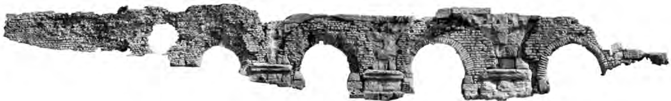
Fig. 154 – PCR « Les aqueducs d'Arles ». Orthophotographie du pont-aqueduc du Vallon Sumian (H. Dessales et F. Marchand Beaulieu).
