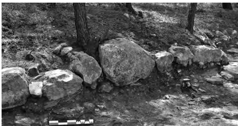
Fig. 125 – MARTIGUES, Tamaris. Le parement externe du rempart nord de l'habitat gaulois – VI e s. av. J.-C. (cliché J. Chaussier-Laprée / SAVM).
