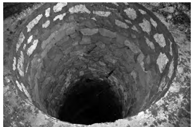
Fig. 137 – MARTIGUES, 38 avenue Kennedy, Ferrières. Puits (cliché V. Canut / SAVM).
