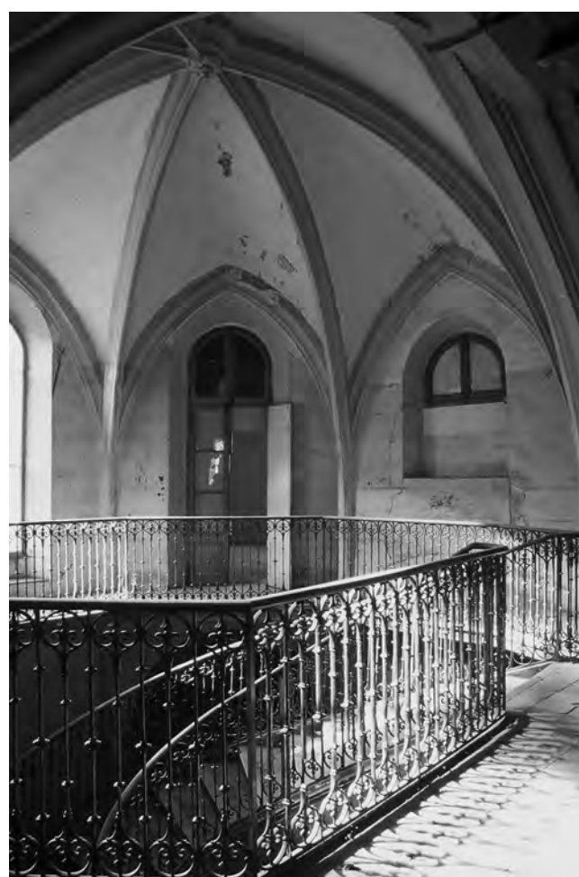
Fig. 199 – PERTUIS, rue Henri Silvy, couvent des Carmes. Vue du chœur de l'église et son escalier du XIX e s. (cliché Fr. Guyonnet / SADV).
