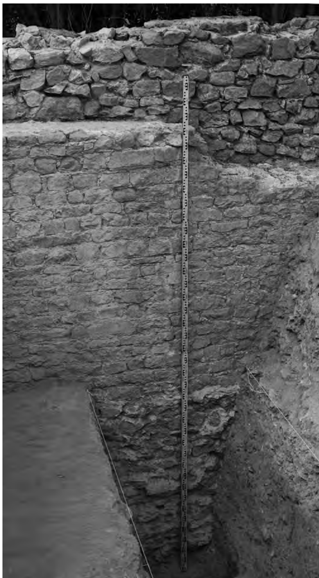
Fig. 163 – FRÉJUS, Butte Saint-Antoine. Parement sud du rempart augustéen au nord du site, repris par un mur d'époque moderne (cliché L. Rivet / CNRS-CCJ).
