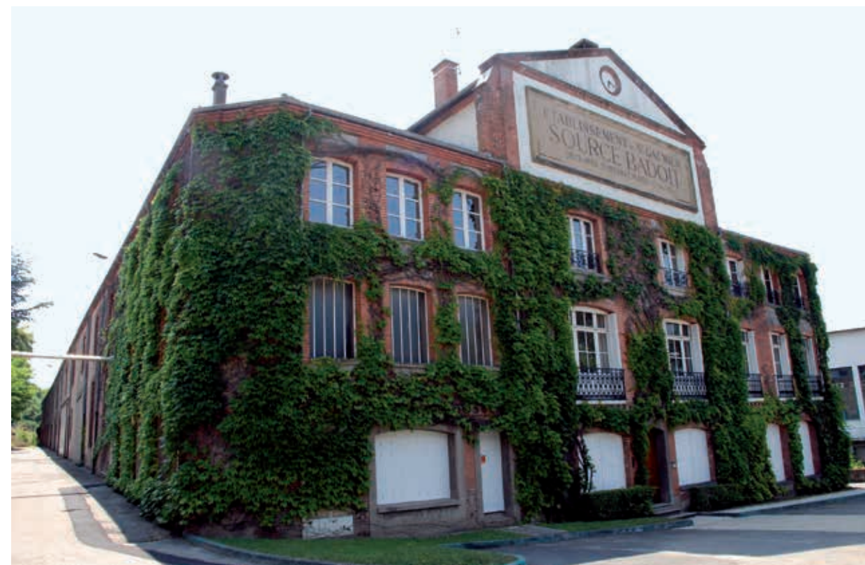
Saint-Galmier, usine Badoit, façade principale de l'ancienne usine.
