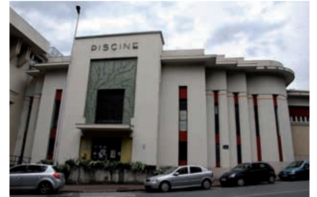
Aix-les-Bains, thermes, piscine Pétriaux.
