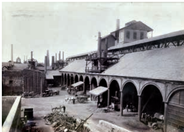
Rive-de-Gier, usine Marrel, galerie bordant la halle, début du XX e siècle.
