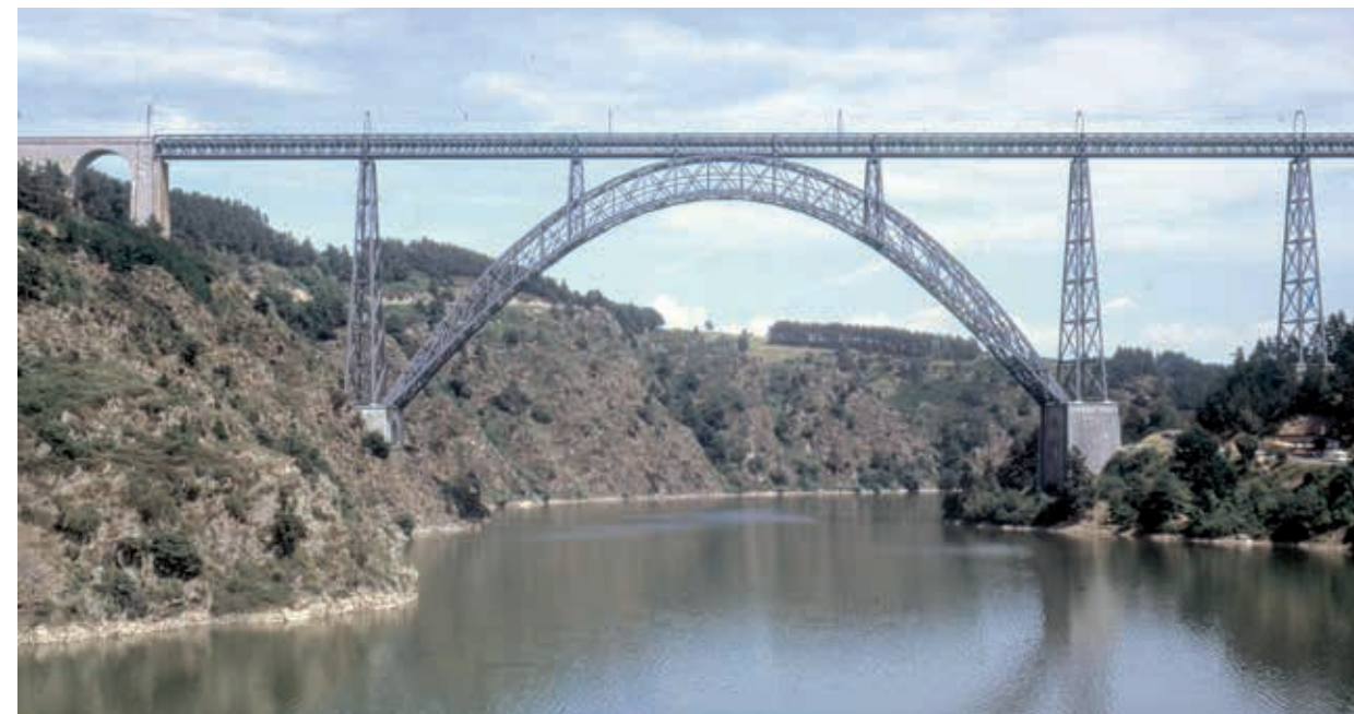
Vallée de la Truyère, viaduc de Garabit vu depuis Anglards-de-Saint-Flour.
