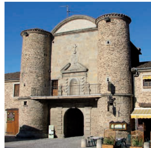
Sainte-Croix-en-Jarez, entrée principale de la chartreuse.
