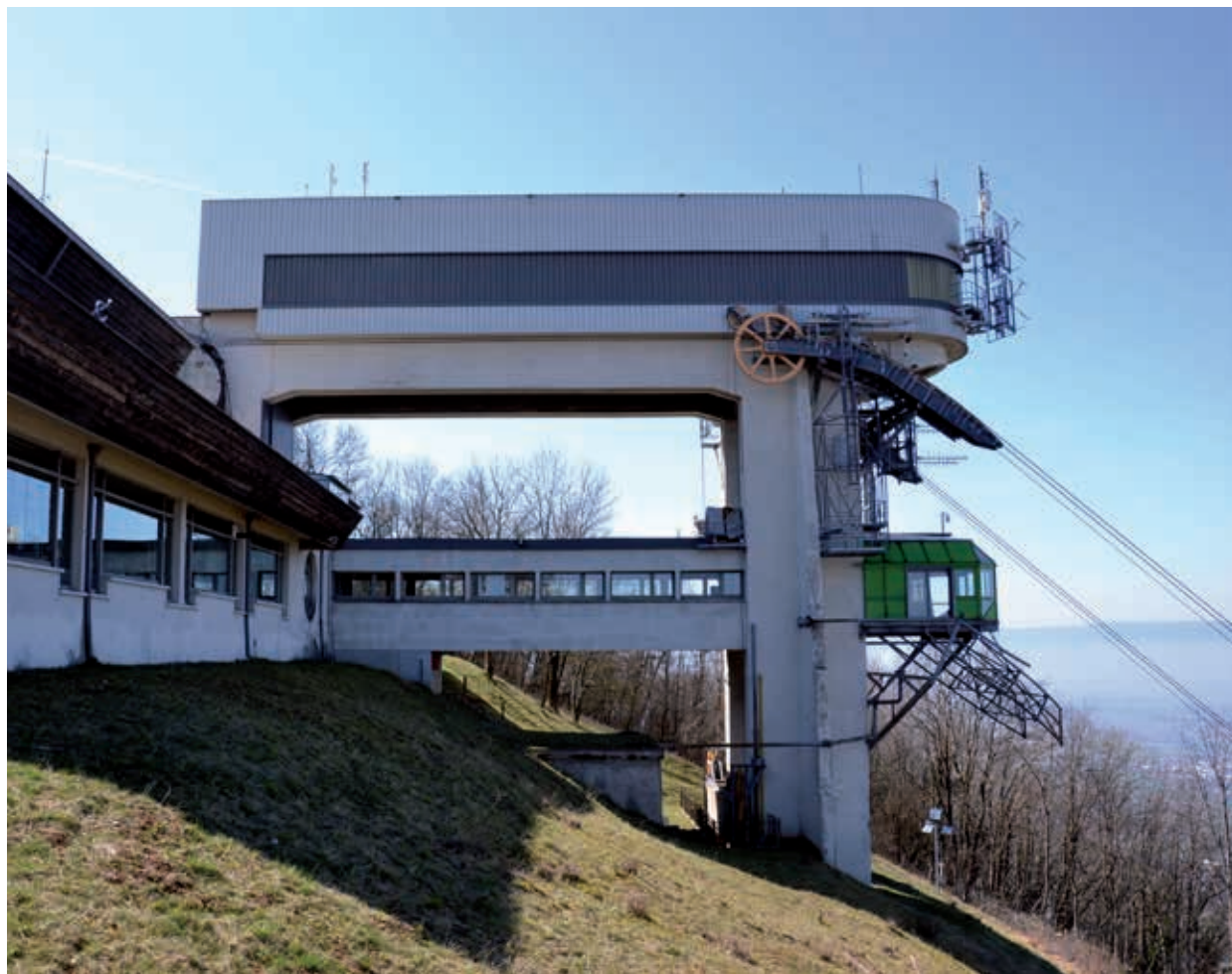
Monnetier-Mornex, proue de la gare haute du téléphérique du Salève.
