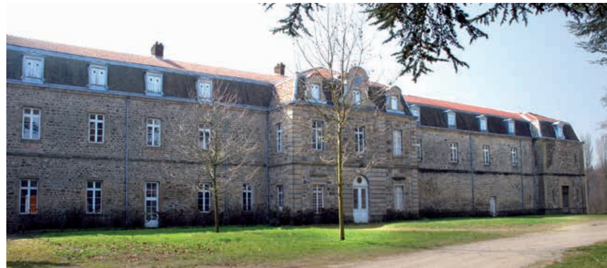
Colombier-le-Cardinal, façade nord de l'aile sud réaménagée en château.
