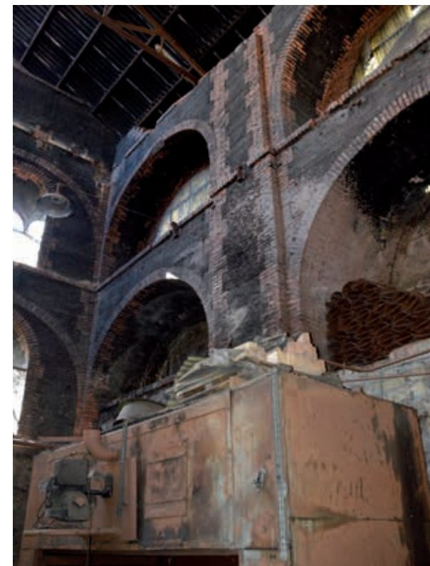
Rive-de-Gier, usine Marrel, intérieur de la tour de trempe.
