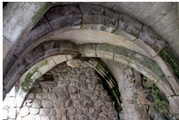
Abbaye Saint-Pierre-des-Chazes, voûtes d'ogives de la galerie du cloître.
