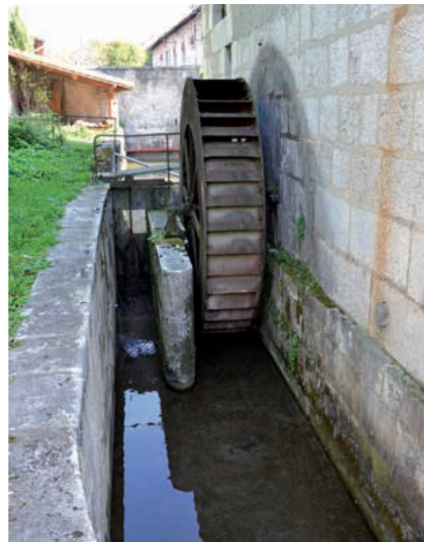
Saint-Gervais-les-Bains, fonderie de canons, la roue et son canal.
