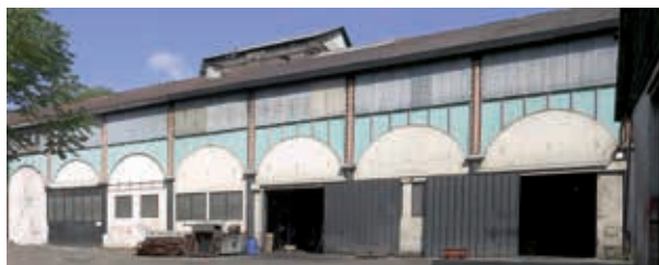
Rive-de-Gier, usine Marrel, galerie bordant la halle fermée.
