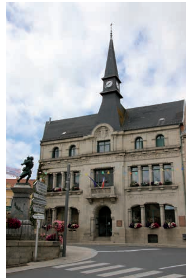
Craponne-sur-Arzon, façade de l'hôtel de ville.
