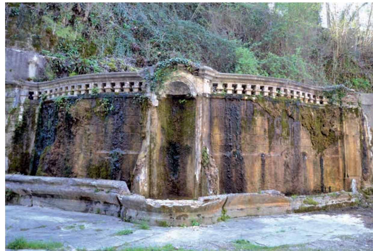
Renage (38), la Grande Fabrique.
