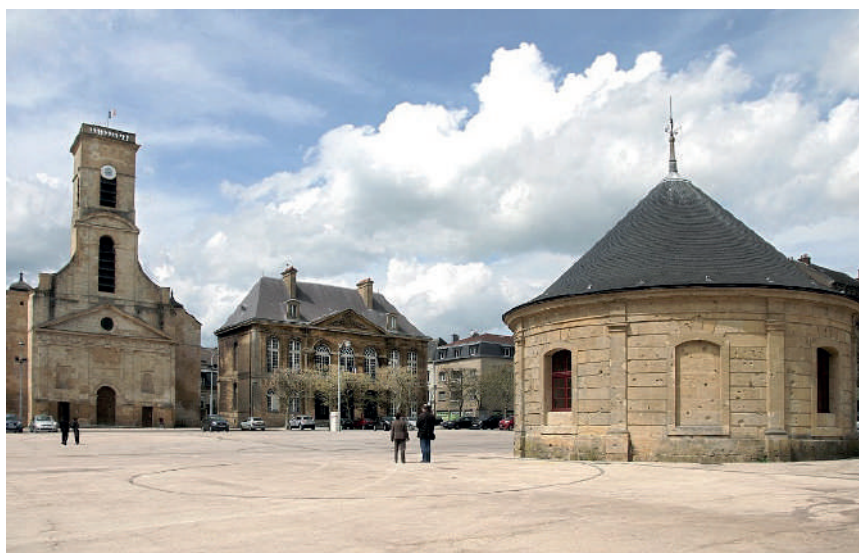
Photo n°09 - Puits de siège (Photo M. Dimanche).
