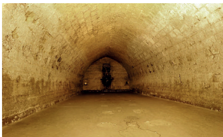
Photo n° 18 – Poudrière saint Martin
