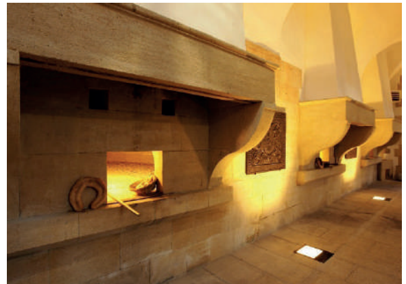
Photo n° 12 – Salle des fours
