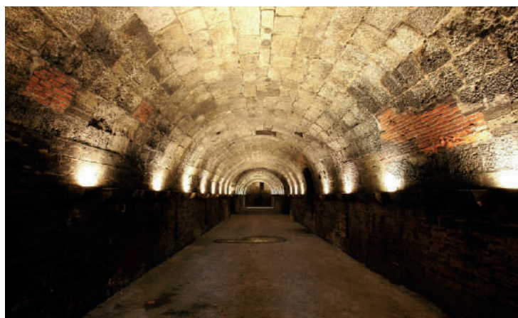
Photo n° 17 – Casemate en croix du bastion Notre-Dame
