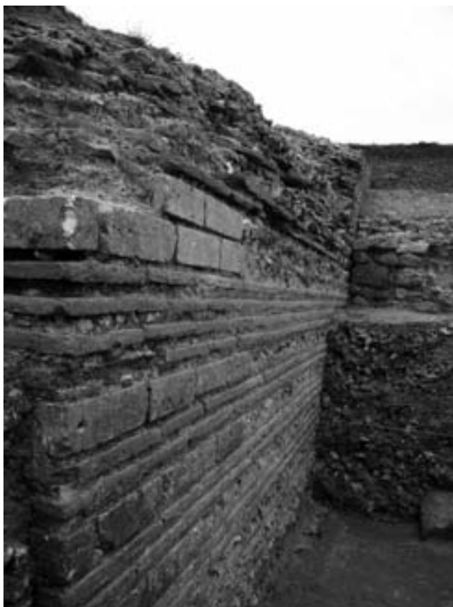
Le Vieil-Evreux, «la Basilique» : Angle de la cella centrale du grand sanctuaire (L. Guyard, MADE)
