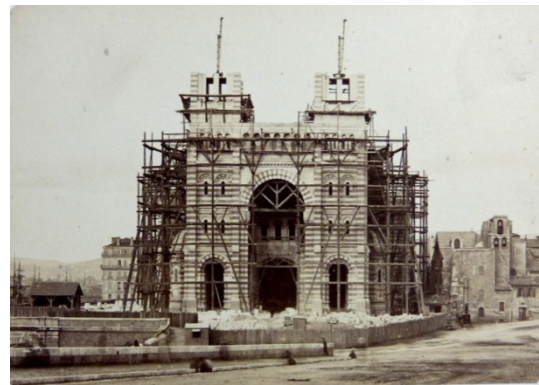
Chantier de la nouvelle Cathédrale. Musée d'Orsay, Fonds REVOIL conservé au Musée des Beaux-Arts de Marseille.
