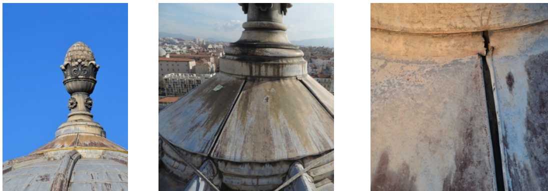
Vues et détails du couronnement des petits dômes
