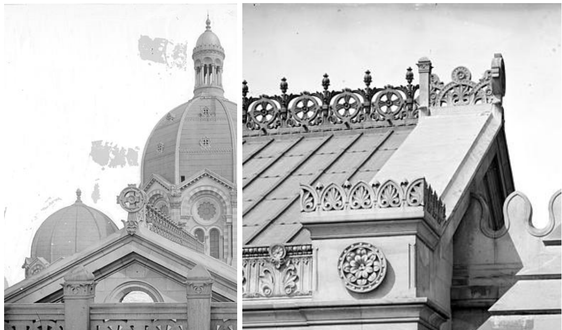
Vues du pignon nord de la nef peu après l'achèvement des travaux. Médiathèque de l'Architecture et du Patrimoine mh013907 & mh013909
