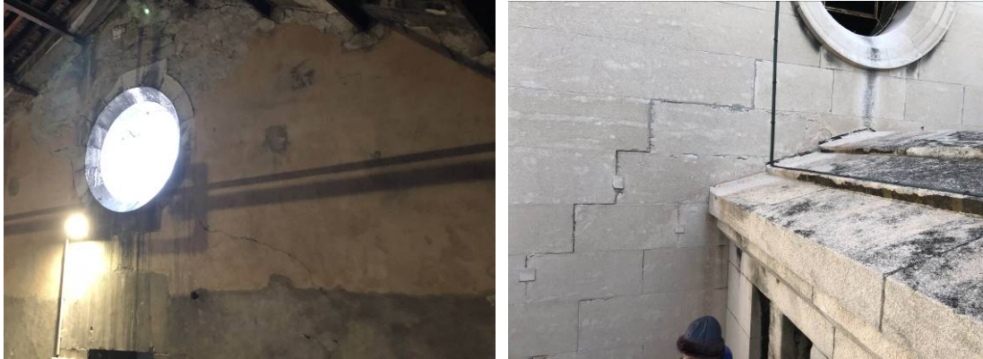
Vues intérieure et extérieure du pignon.
