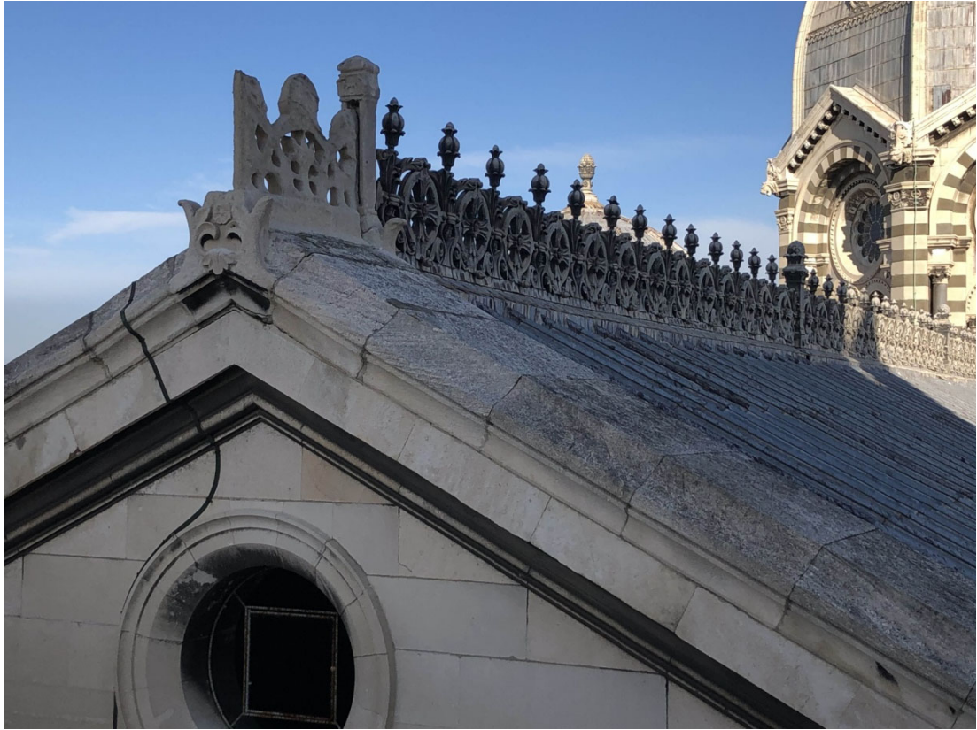
Etat actuel du pignon sud de la nef.
