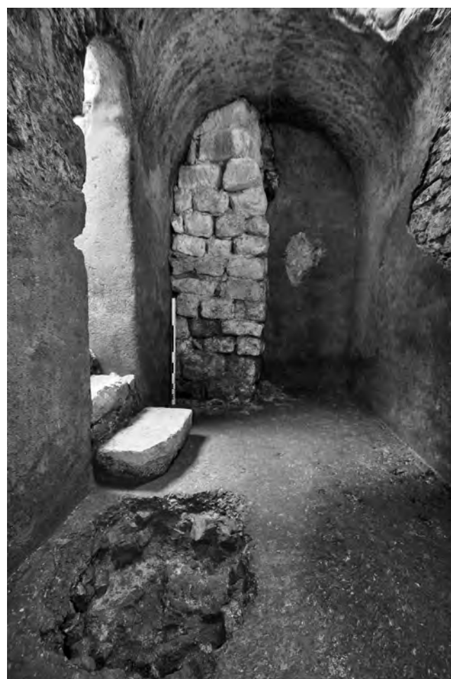
Fig. 47 – PCR « colline du Château à Nice ». Vue de l'intérieur de la citerne antique, située sous la cathédrale (cliché L. Damotte / SAVN).
