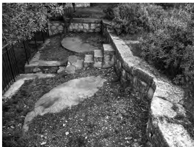
Fig. 51 – NICE, Batterie mont Boron. Plate-forme de tir, avec un muret en arc de cercle convexe correspondant à l'emplacement du canon sur le cercle en terre.
