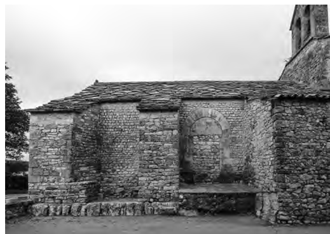
Fig. 10 – SAINT-MICHEL-L'OBSERVATOIRE, église Sainte-Madeleine de Lincel. Vue du gouttereau sud depuis l'extérieur (cliché SDA04).
