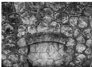
Fig. 50 – NICE, batterie. Appareil en pierres à bossage et joints taillés en creux. Ouverture murée avec un ciment décoré d'incisions réticulées (cliché H. Geist).
