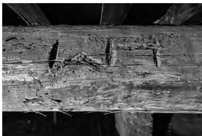
Fig. 34 – CANNES, Notre-Dame d'Espérance. Marque de charpentier modifiée (cliché F. Blanc).
