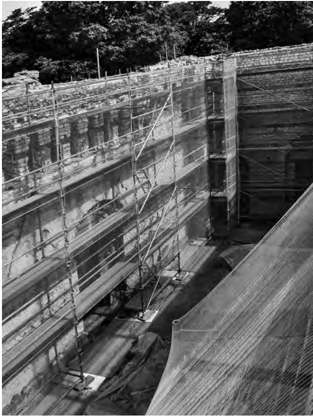
Fig. 41 – Élévations intérieures nord et ouest du frigidarium en chantier (cliché É. Sanchez / SAVN).
