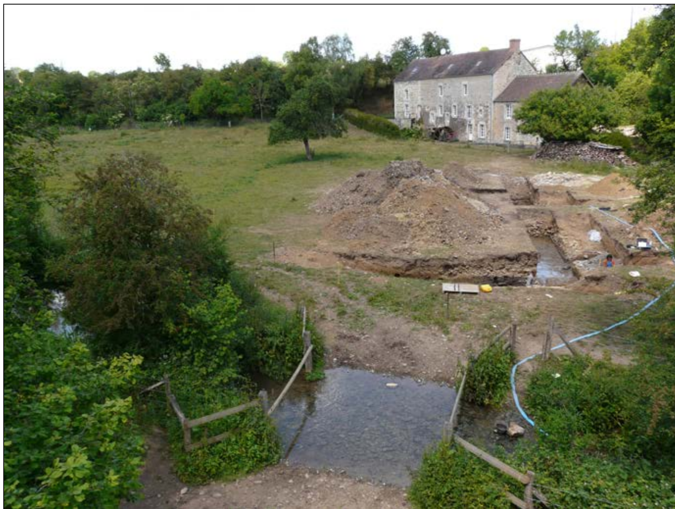
Fig. 1 - Vue générale de la tranchée réalisée dans le fond de la vallée de la Guigne à VIEUX ; en arrière plan, le Moulin Neuf (cliché P. Mazure, CG 14).
