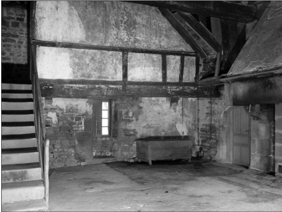
Fig. 36 - Logis du manoir de Lerre : vue de la galerie depuis le seuil de la porte d'accès principale à la salle ; à gauche, l'escalier en granite menant à cette galerie.
