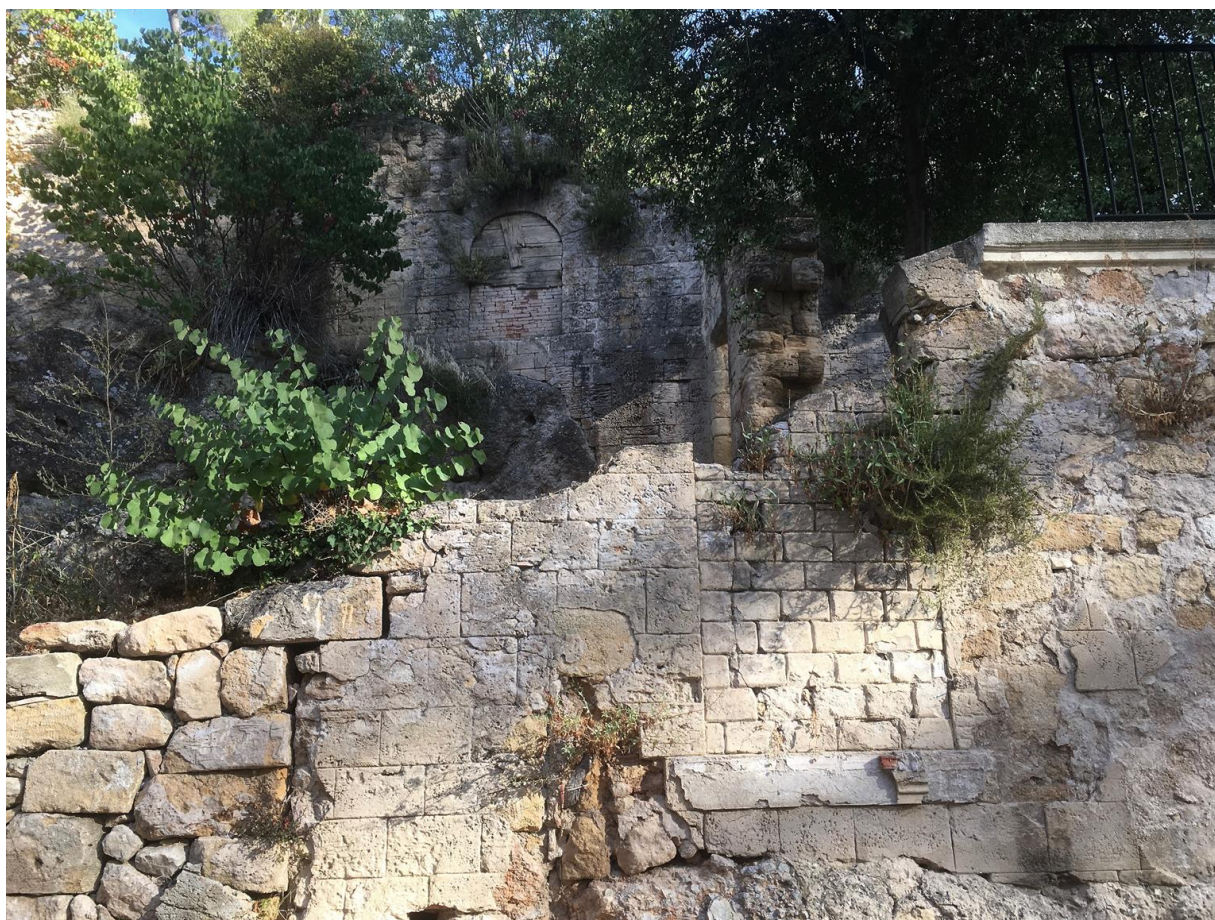
Fig. 1. Fausses ruines en rocaillage, fin XIXe. Parc du château du Tholonet, Le Tholonet (Bouches-du-Rhône) © Y. Cranga, 2017
