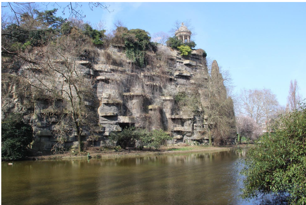
Fig. 30. Falaise est de l'île avec jardinières en béton. Parc des Buttes-Chaumont (Paris) © I. Lévêque, 2011
