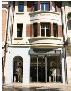
Elles s'insèrent dans les éléments maçonnés existants (pierre ou béton). Dans certains cas, les éléments disparus qui entraient dans la composition ou la structure de la façade seront restitués à partir des éléments subsistants : jambages, linteaux et arcs, piliers, éléments décoratifs, pour la plupart en pierre de taille.
