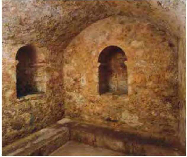
fig. 14 - Descente vers le bain. Au premier plan, on remarque la partie retaillée de la voûte en berceau.
