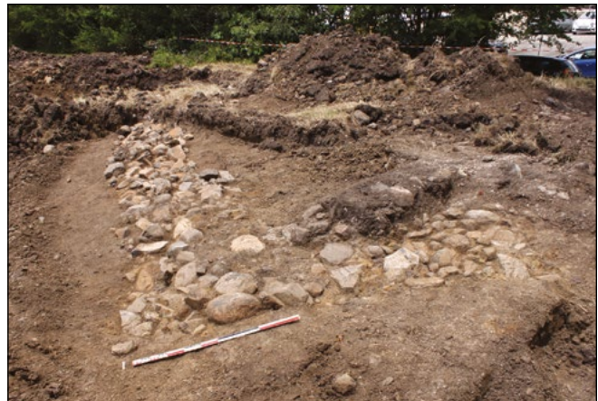
Fig. 2 Vue de l'angle nord de la fondation du bâtiment vers le sud. © A. Coulaud (Inrap)
