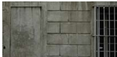
Mortier de ciment
