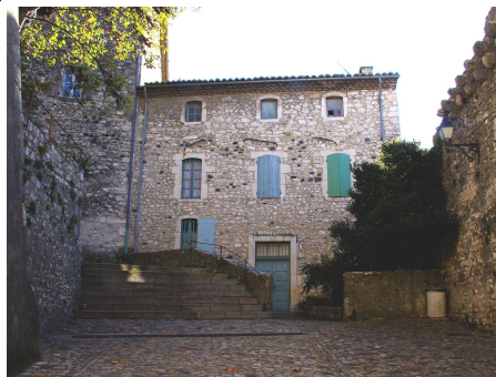
A l'échelle du bâtiment (Viviers)
