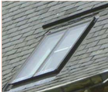
Type de châssis de toit autorisé en référence au modèle traditionnel de la tabatière
