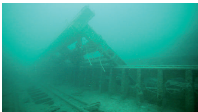
Fig. 5 a et b. Le pont mobile est constitué d'un tablier mobile portant un train de rails, d'un portique permettant son relevage et d'un jeu de treuils et de poulies pour actionner l'ensemble. Tous ces éléments sont encore présents sur le site ; le tablier est incliné, chevauchant en partie la rambarde tribord du plan incliné central (cl. M. Huet et F. Mathieu).
