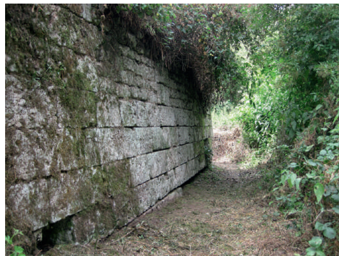
Fig. 15. Montlivault (41), mur de soutènement d'une ancienne levée mis en œuvre par Colbert (cl. © C. Peschang, PCR Épaves et naufrages 2015).
