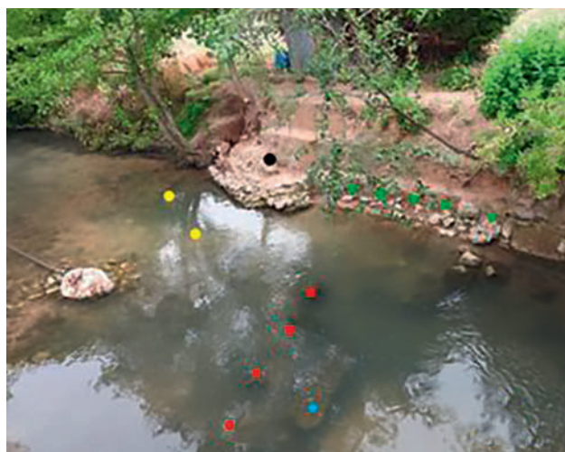
Fig. 23. Rive et coursier aménagés.
