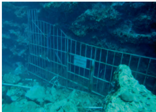
Fig. 26. Portail mis en place vu de l'extérieur.
