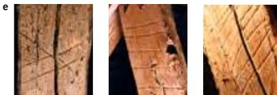
Les techniques de marquage utilisées par le charpentier pour numérotter les fermes emploient des séries de bâtonnets (e) et l'usage de différents outils pour distinguer les pièces de bois qui seront placées à droite ou à gauche de la charpente. Ces particularités caractérisent les charpentes les plus anciennes, ce que confirment les datations dendrochronologiques : l'abattage des arbres se situe entre 1212 et 1228.
