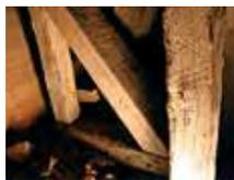
\* ferme : élément de charpente de forme triangulaire, non déformable, supportant le poids de la couverture d'un édifice et placé perpendiculairement aux murs gouttereaux.
